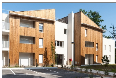
L'Oréjalle, à Saint-Médard-en-Jalle 58 logements BBC (Bâtiment Basse Consommation), avec une loge de gardien
